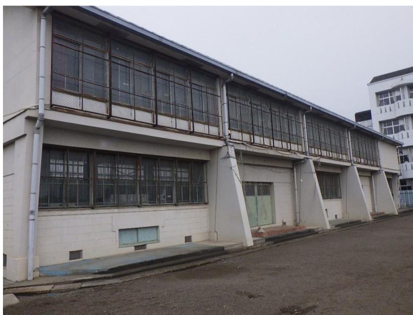
改修前 東側外観
