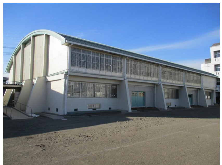
改修後 東側外観
