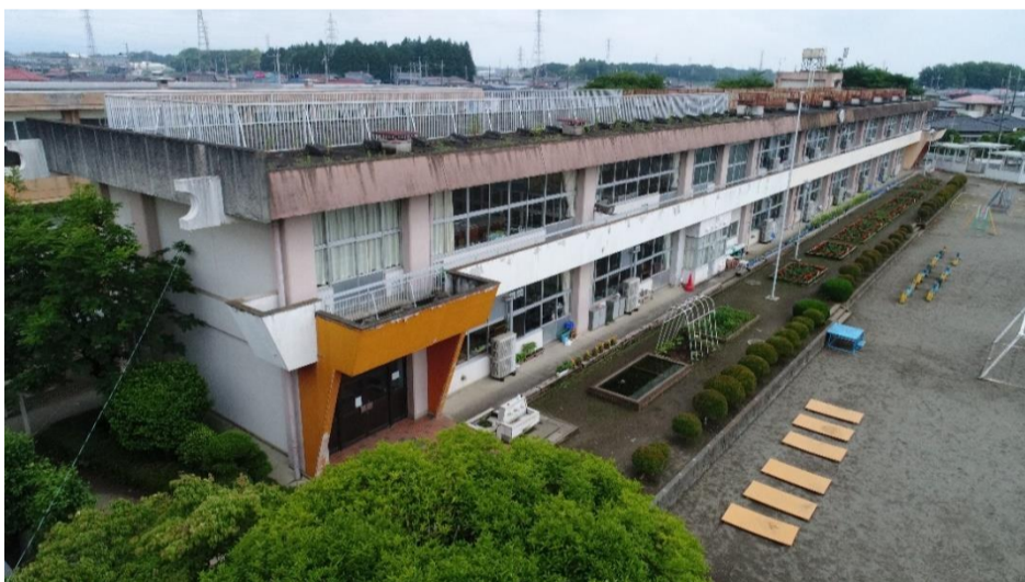
校舎南側外観改修前
