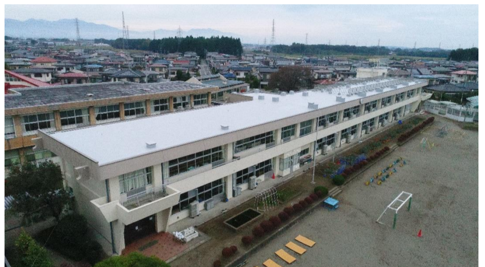
校舎南側外観改修後
