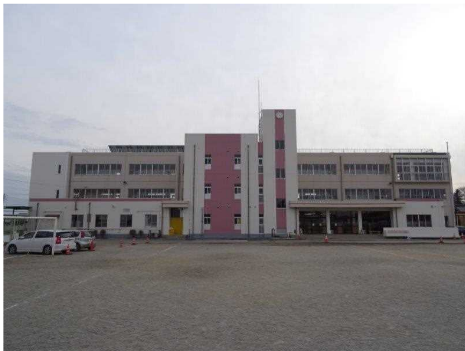
管理教室棟 全景
