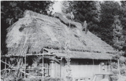
結によるかやぶき屋根のふきかえの様子 (昭和期 那須塩原市 (旧西那須野町) 那須塩原市那須野が原博物館提供)
