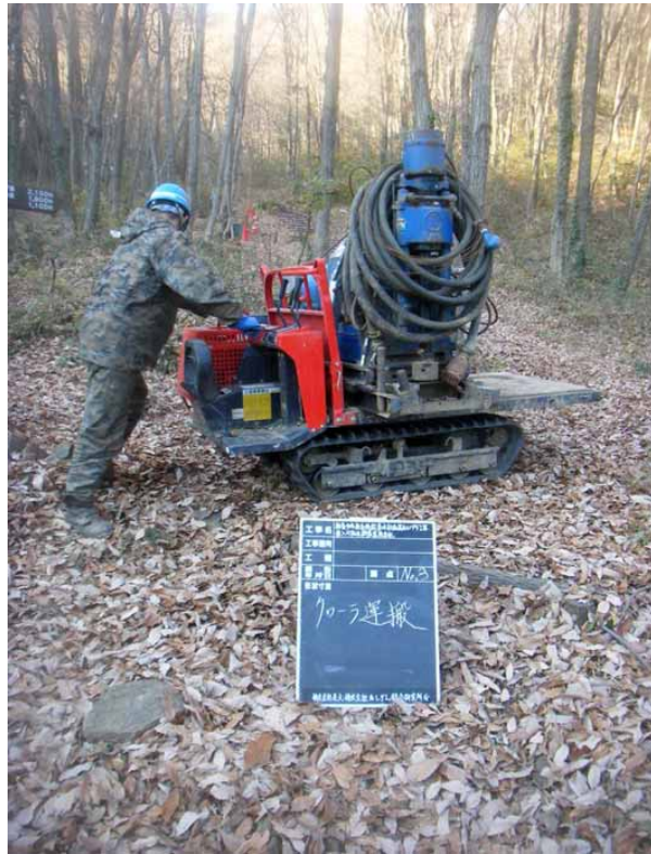
クローラ運搬状況(1)
