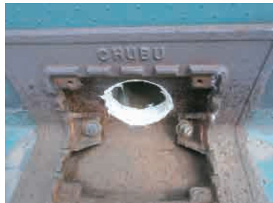
排水溝作業後
