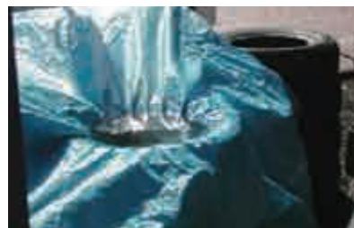
雨よけシートのくぼみ ⇒たるみを無くして雨をためない
