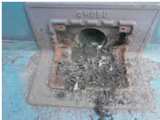
排水溝作業前
