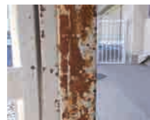
柱・柵のサビの除去・塗装
